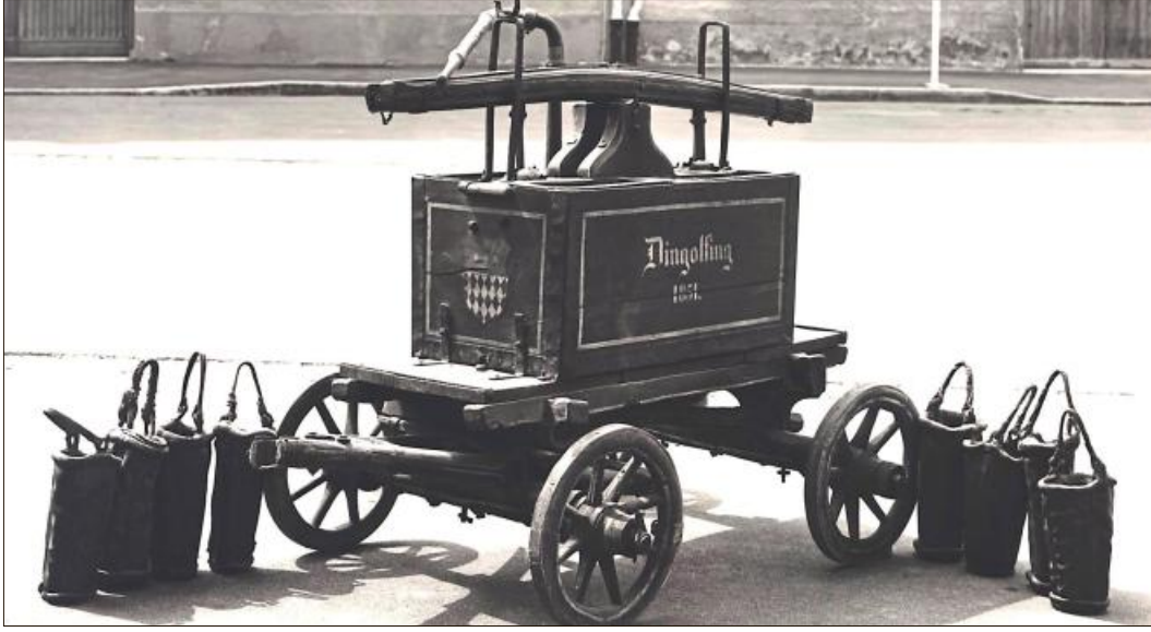
Aus den Anfängen der Dingolfinger Feuerwehr: Eine Handspritze. Mit den Ledersäcken wurde der Tank befüllt, ein Schlauch angeschlossen, eine Bedienmannschaft hat dann die Pumpe betätigt. Heute hat die Dingolfinger Feuerwehr Pumpen, die 2 500 Liter pro Minute schaffen.
